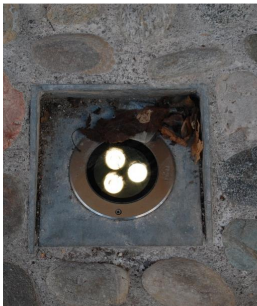
Figura 54: Apparecchi illuminanti a LED utilizzati per illuminazione avvolti nel centro storico di Calavino
