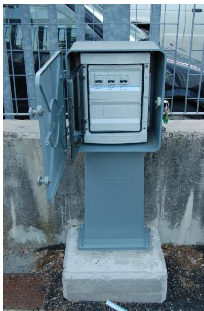
Figura 30: Particolare quadri di sezionamento linee I.P. a Sarche in via Laghetto.
