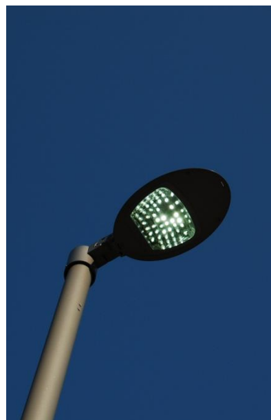
Figura 61: Particolare sistema illuminante con tecnologia a LED
