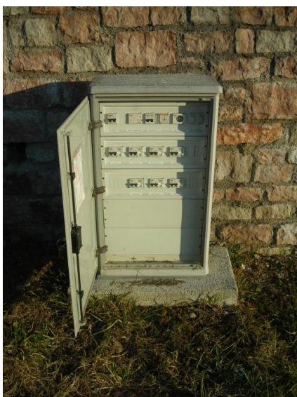
Figura 14: Quadro elettrico generale I.P. a Calavino (Q.CALAVINO 3).
