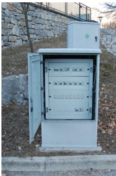
Figura 20: Quadro elettrico generale I.P. a Calavino (Q.CALAVINO 4).
