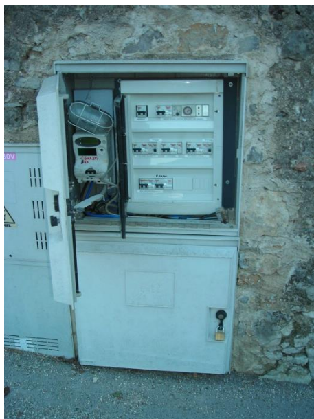
Figura 18: Quadro elettrico generale I.P. a Calavino (Q.CALAVINO 5).
