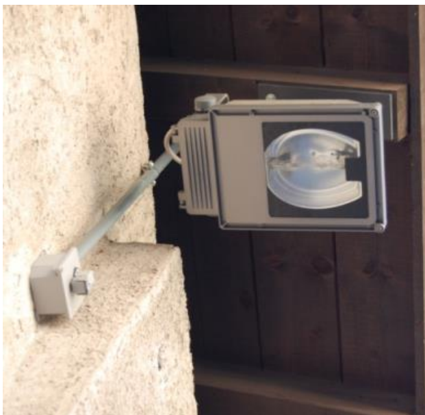
Figura 55: Proiettori installati sotto-gronda per illuminazione strade del centro storico a Calavino
