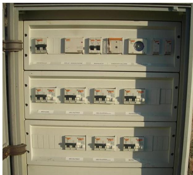
Figura 15: Particolare quadro elettrico generale I.P. a Calavino (Q.CALAVINO 3).
